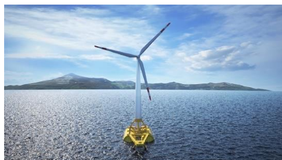
Imagen de lo que será el aerogenerador una vez instalado en el mar. La base tendrá 64 metros de largo. Foto: DEIA
